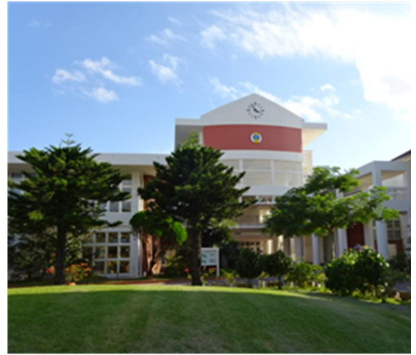
管理棟（左側）及び中央棟
